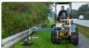
Kant-/Stolpklippare RI monterad.
