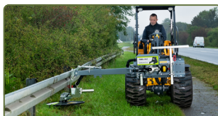
Kant-/Stolpklippare RI monterad.
